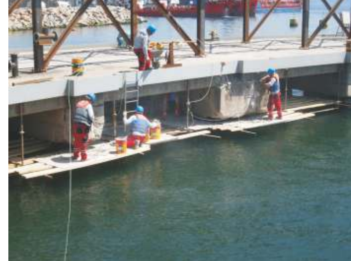
Betonarme İskele Onarımı
