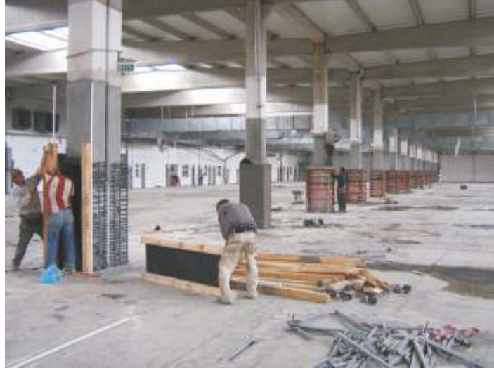
Betonarmede Kolon Mantolama
