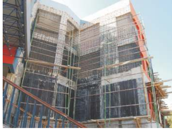
Betonarme Perde İlavesi
