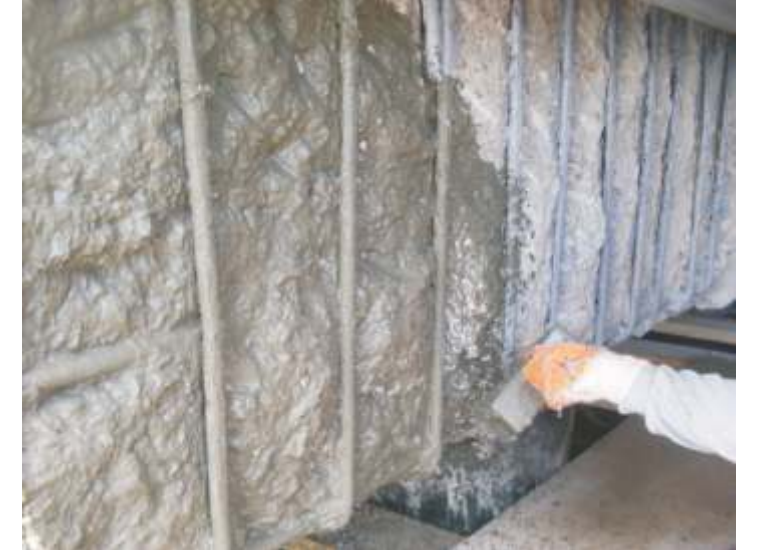
Betonarmede Korozyon Onarımı
