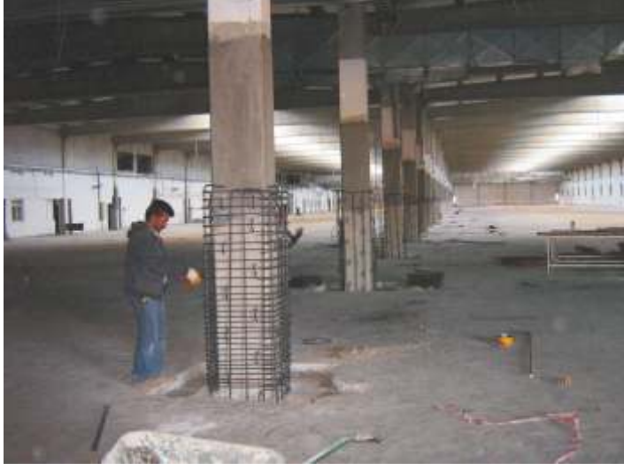
Betonarmede Kolon Mantolama
