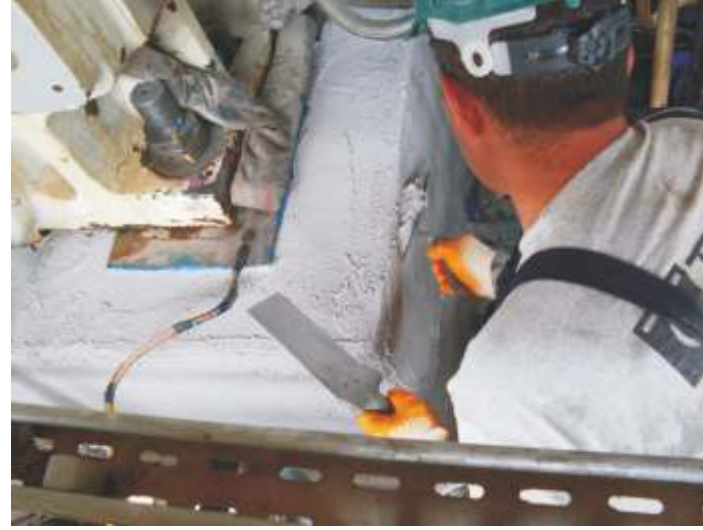
Makine Temeli Güçlendirme
