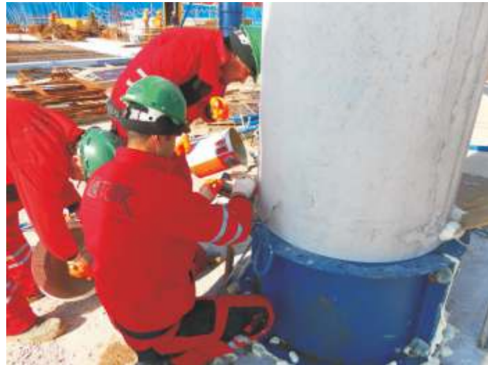
Betonarmede Epoksi Harçlar İle Onarım
