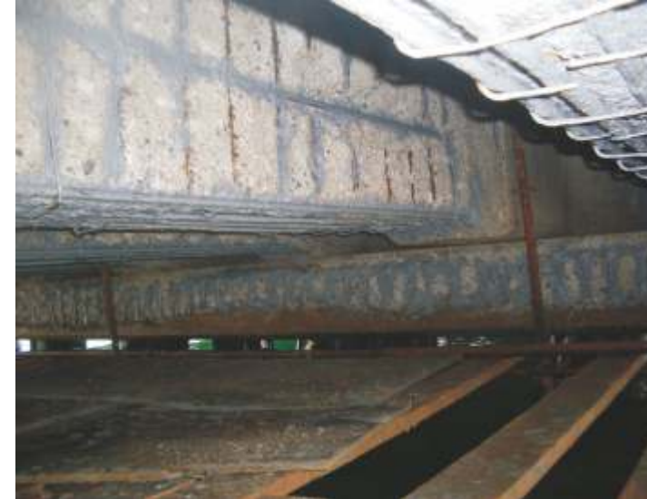
Betonarmede Korozyon Onarımı
