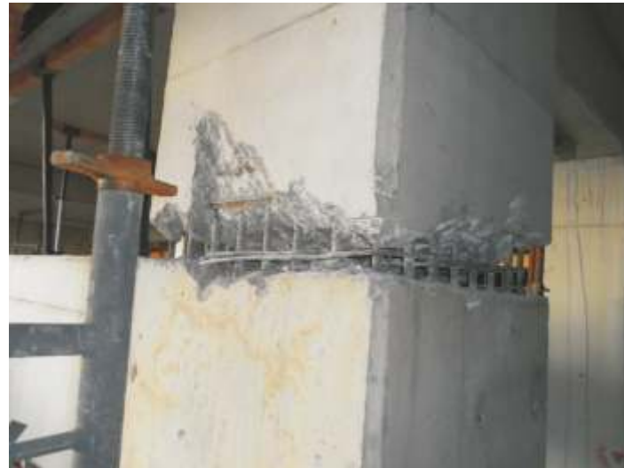
Betonarmede Epoksi Harçlar İle Onarım
